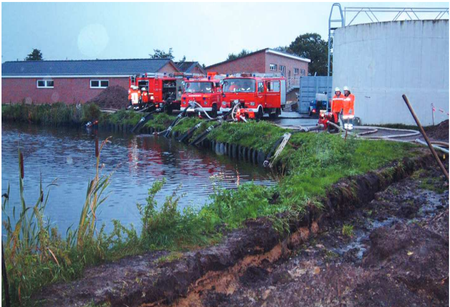
Abpumpen der Schönungsteiche beim Klärwerk Gnarrenburg
