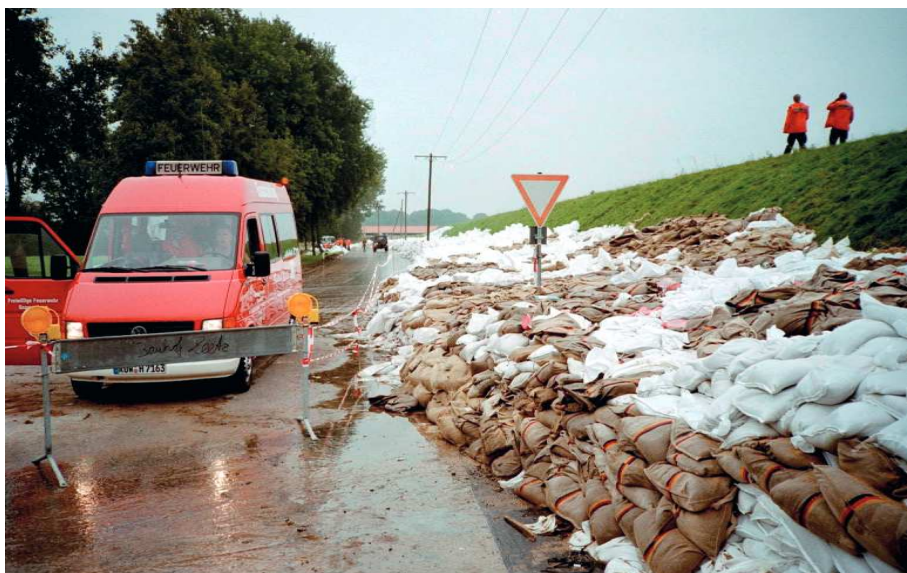
Einsatz der Kreisfeuerwehrebereitschaft: Deichsicherung im Amt Neuhaus
