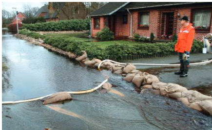
Hochwasser-Sicherung der Wohnhäuser in Augustendorf
