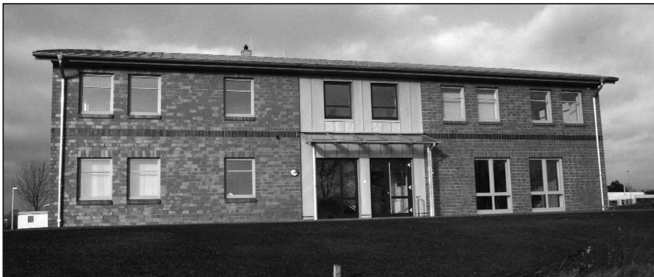
Ansicht auf das Verwaltungsgebäude von der neuen Entlastungsstraße: in dem zweigeschossigen Gebäude der Bremervörder Ortsfeuerwehr befinden sich die Schulungsräume und die Büros der Führungskräfte.
