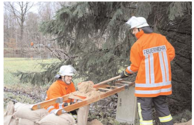
Sandsäcke werden gefüllt (Ober Klenkendorf)
