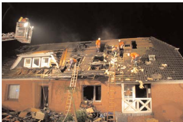
Bis in die frühen Morgenstunden wurde unter dem abgedeckten Dach nach Brandnestern gesucht.
