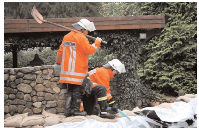
Sandsackwall, Einsatzkräfte pumpen das Wasser aus dem Haus in den Garten (Ober Klenkendorf)
