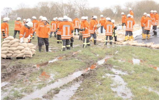
Feuerwehrkameraden aus Bremervörde sowie der aus der Gemeinde Gnarrenburg und der Samtgemeinde Geestequelle stabilisierten den Deich mit Sandsäcken.
