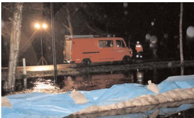
Provisorischer Deich Augustendorf
