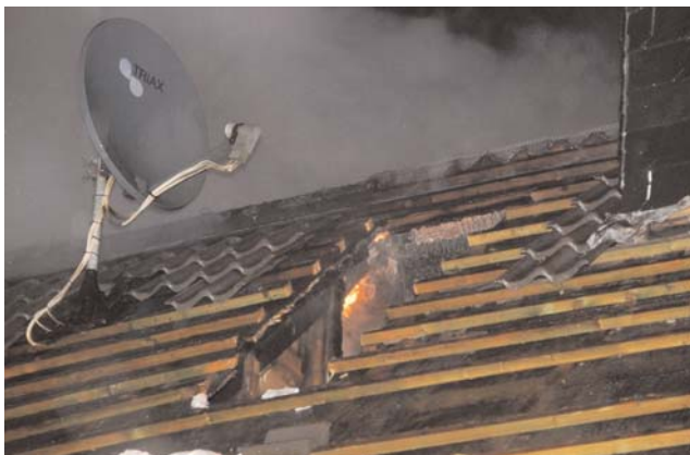
Das dritte Feuer wurde im Spitzboden durch heftigen Wind entfacht.
