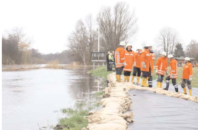
Rund 80 Feuerwehrkameraden versuchten den gefährdeten Deichabschnitt mit Sandsäcken zu sichern.
