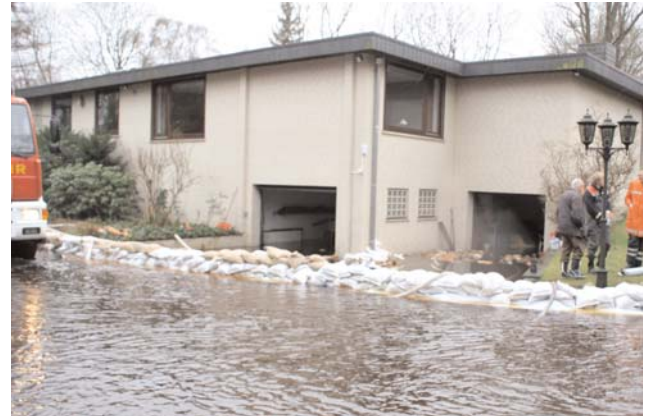
Dieses Haus, das direkt am Flusslauf der Oste liegt, konnte nicht vor den Wassermassen gerettet werden.
