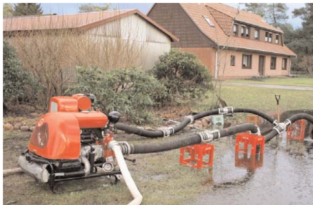
Pumpen im Dauereinsatz (Augustendorf)
