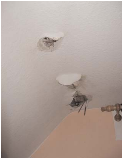
Deutlich zu erkennen: Aufgeplatzte Decke in Folge des Blitzeinschlages
