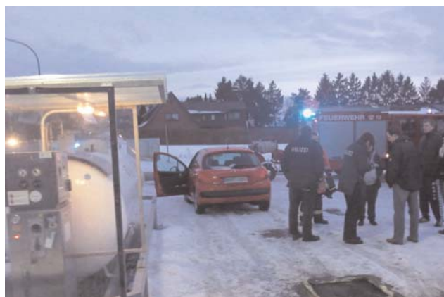
Der Füllschlauch der Flüssiggastanksäule riss an der Sicherheitskupplung ab
