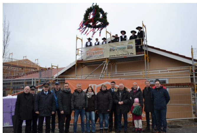
Von der Planung bis zum Richtfest war es ein sehr langer Weg. Doch am Sonnabend wehte endlich der Richtkranz über dem künftigen Hesedorfer Feuerwehrgerätehaus. Zahlreiche Gäste nutzten die Gelegenheit, sich einen ersten Eindruck vom künftigen Domizil der Brandschützer zu machen.
